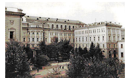
Conservatório de Moscovo
